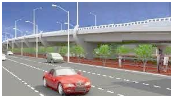
Un “Super Paquete” de Obras es lo que requiere Acámbaro para desarrollarse como un municipio propio del siglo XXI, entre ellas, la del Puente Elevado para evitar el bloqueo del Ferrocarril en el sector de “La Maquinita”.
